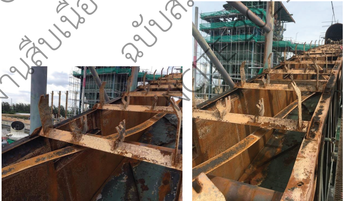
รูปที่ 9 ตัวอย่างโครงถักที่เกิดความเสียหายจากการโก่งเดาะ
