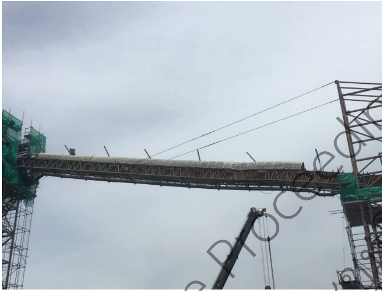
รูปที่ 10 โครงถัดที่เกิดการแอ่นตัว
