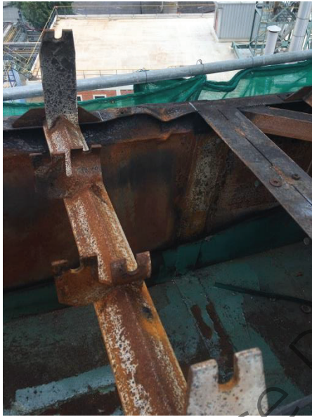
รูปที่ 3 ตัวอย่างชิ้นส่วนที่ถูกไฟไหม้
